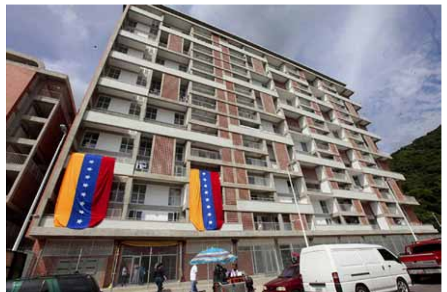
Constructora de viviendas masivas
