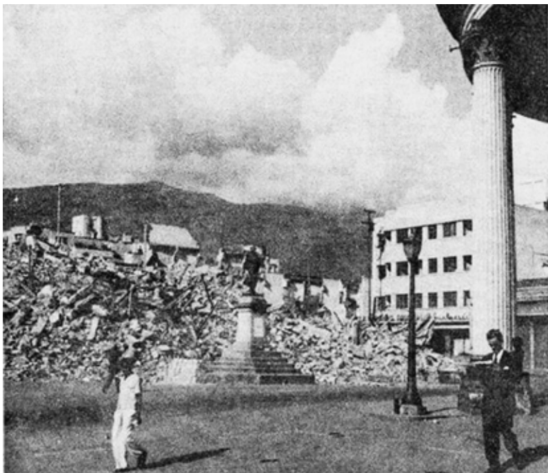
Demolición del hotel 1949.
