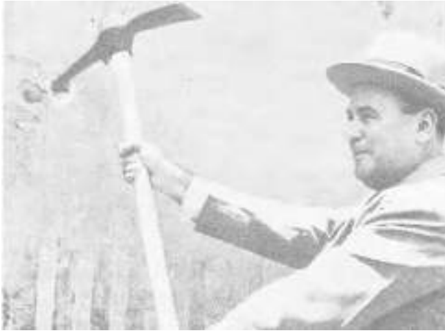
El Presidente Medina inaugura los trabajos de demolición de la antigua barriada de El Silencio, para construir la nueva urbanización proyectada por el arquitecto Carlos Raúl Villanueva.
