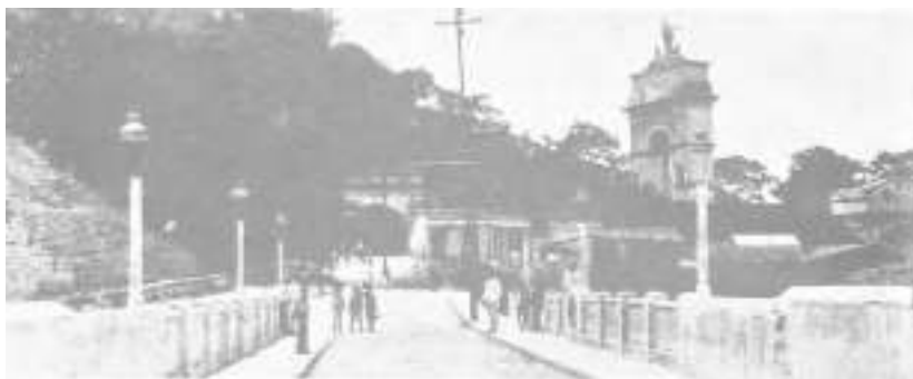
El antiguo Puente Bolívar que daba acceso a El Calvario desde el centro de la ciudad. El Puente desapareció y la quebrada fue embovedada para construir una parte de la reurbanización de El Silencio.
